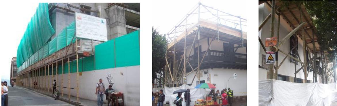
Figura 1: Exemplos de escoras e andaimes em bambu na Colômbia. Fonte: Um dos autores, (2010)
