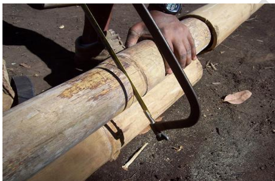
Figura 3.28. Corte da peça interna.
