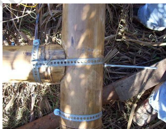
Figura 3.12. Boca de pescado reforçada
