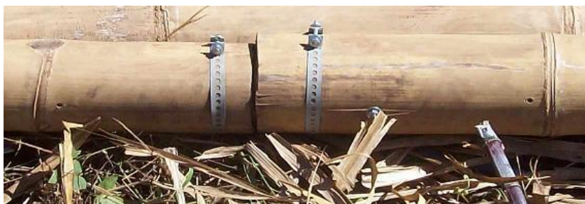
Figura 3.32. Uso de braçadeiras de aço evitando o aparecimento de fissuras.
