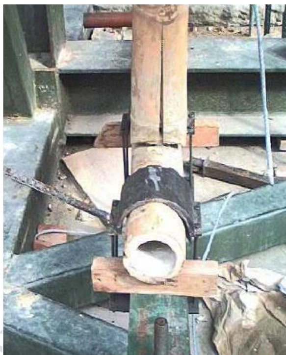
Figura 3.25. Ruptura da Conexão SV 90° à tração.
