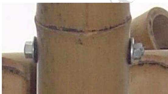
Figura 3.31. Sistema porca, arruela de aço, arruela de PVC.
