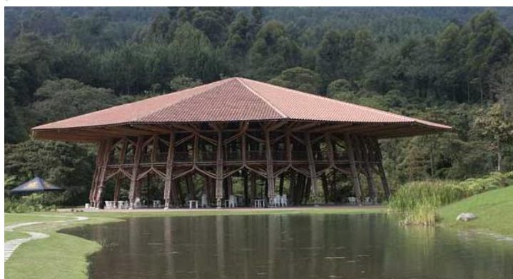
Figura 3.38. Exemplo de sistema de beirais para proteção contra intempéries (Simon Velez).
