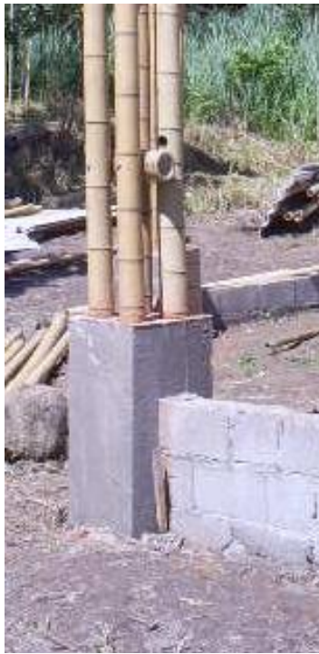
Figura 3.2. Base de concreto.
