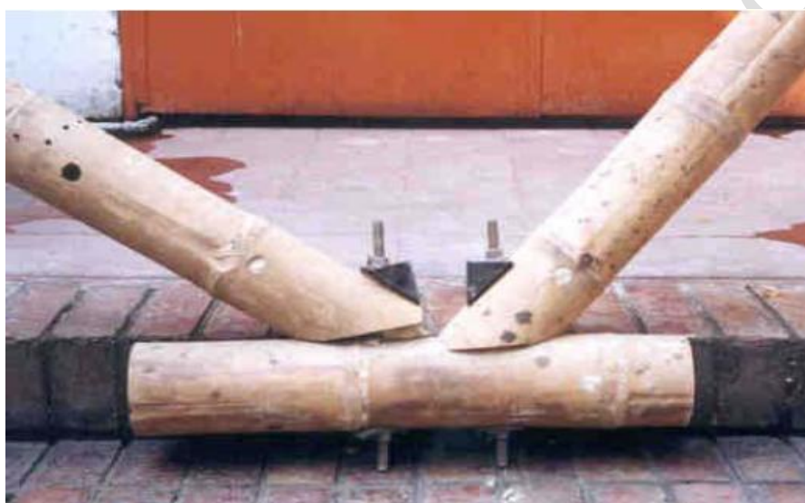
Figura 3.19. Ruptura da conexão SV 45° devido a tração.
