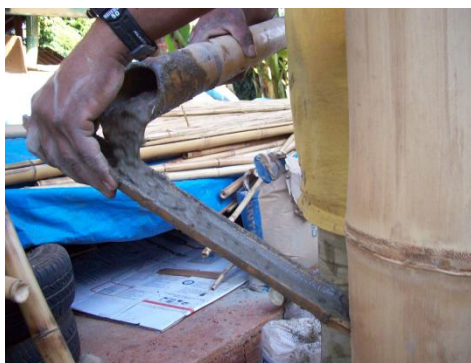
Figura 3.5. Preenchimento da vara com concreto usando pedaços de bambu.
