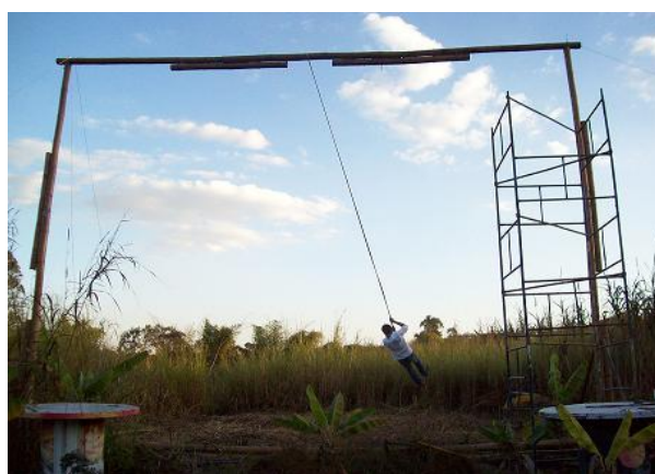
Figura 2.15. Exemplo de carga pontual em uma peça submetida a flexão estática.
