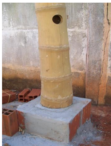
Figura 3.3. Abertura para preenchimento da vara com concreto.
