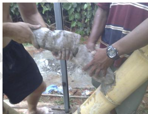
Figura 3.6. Preenchimento da vara com concreto usando garrafas pets.
